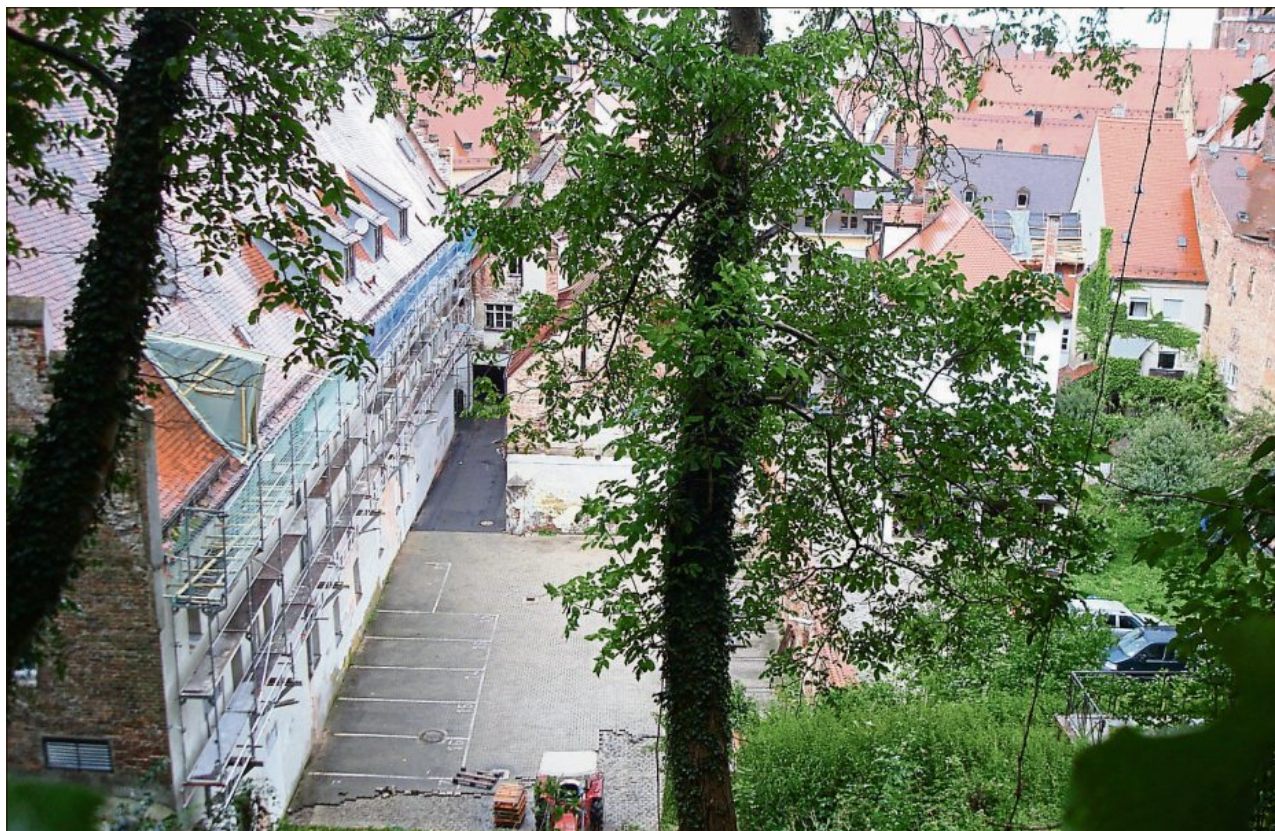
Die Rückseite des Moserbräus, an dem die Durchfahrt verbreitert und ein Stahlträger eingezogen wurde. Der Eigentümer ist der Ansicht, dass er keine Genehmigung dafür braucht. (Foto: Altstadtfreunde)
